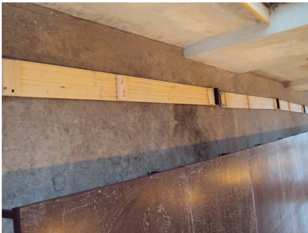
Pohled na boční dřevěné krytí před montáží
