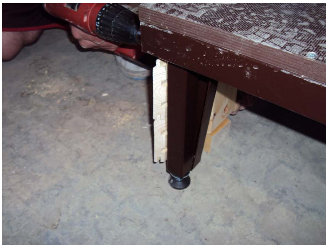
Detail přichycení profilu k nožce podia
